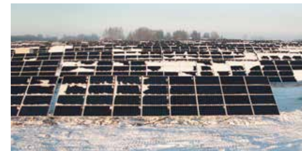
Abbildung 1 – Mismatch aufgrund von Verschmutzung
